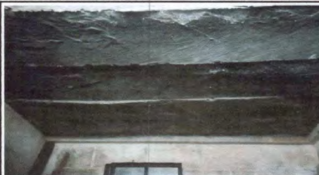
Foto 4: Impermeabilización de losa
