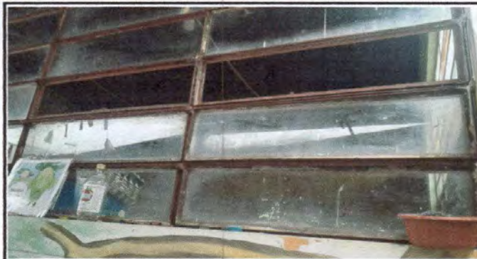
Foto 2: Sustrución de vidrios
