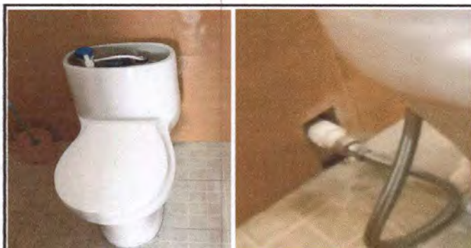
Foto 6: Cambio de contrallaves
