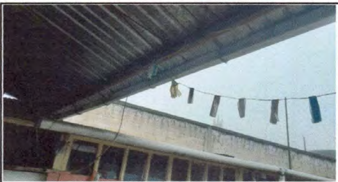
Foto 4: Sustrución de canal de pvc
