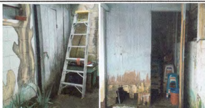
Foto 5: Sustitución de puertas
