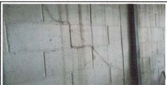
Foto 6: Reparación y Tallado de Grietas en Paredes
